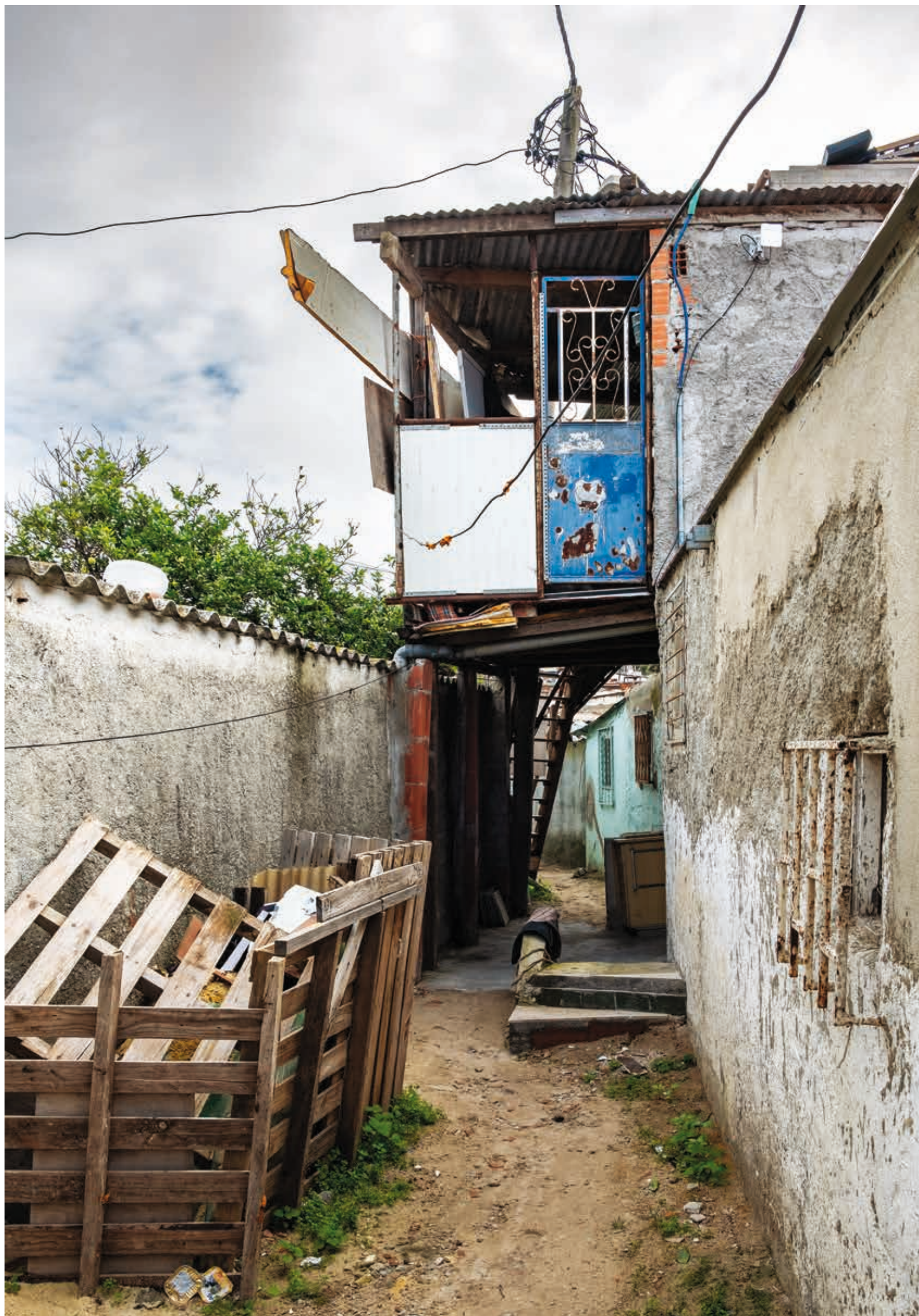
Sem ordem O bairro cresce sem planeamento em torno de ruas estreitas, com casas inacabadas e numeradas à mão
