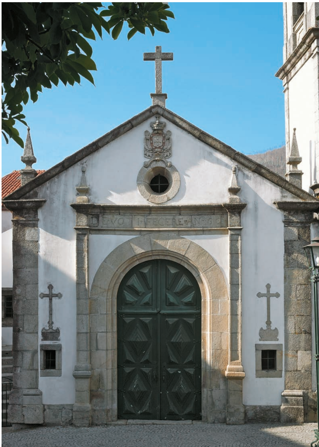
III Fachada da Igreja da Misericórdia de Arouca, ca. 1612 Arouca (Fotografia: Sérgio Azenha)
