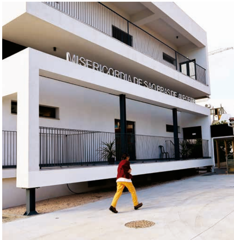
Obra Com esta intervenção, a capacidade passou para 85 utentes, mais 10 do que atualmente
